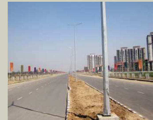
Actual sector road on the frontage of Maceo
